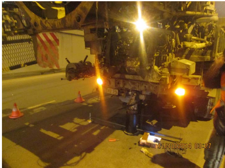
Фото 10. Испытание жестким штампом с установкой на асфальтобетон
