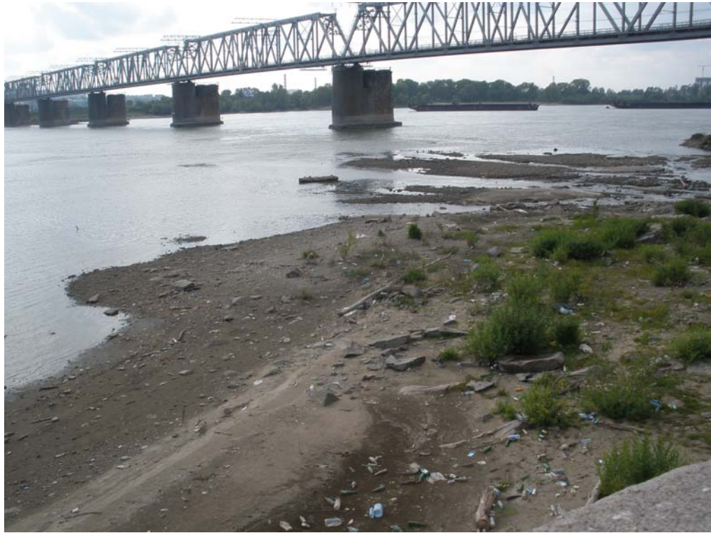
Фото 23. Точка наблюдения 4. Правый берег р. Обь. Вид на железнодорожный мост.
