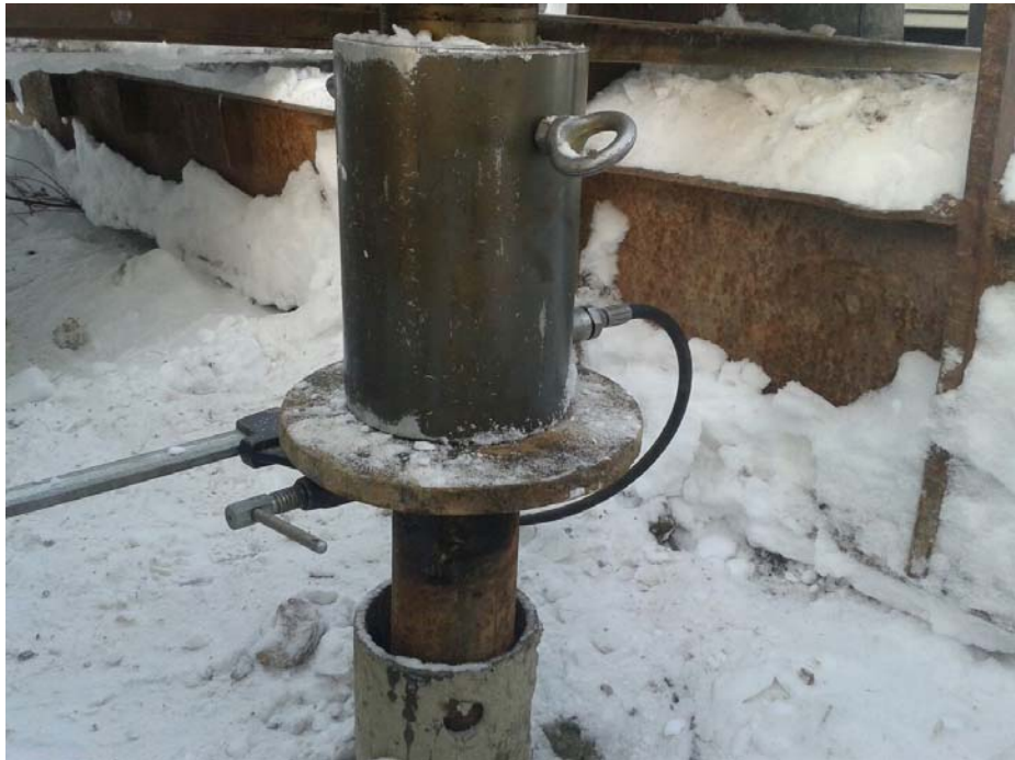
Фото 11. Испытание грунтов штампом с плоской подошвой площадью 124,6 см 2
