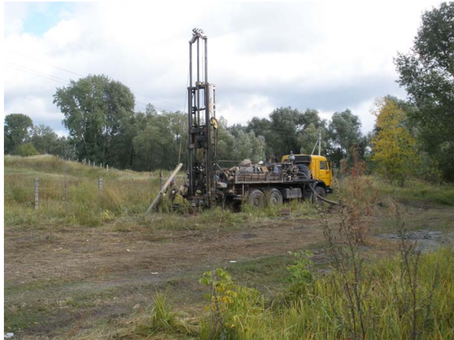
Фото 1. Бурение скважины 218795 в створе основного хода (левый берег)
