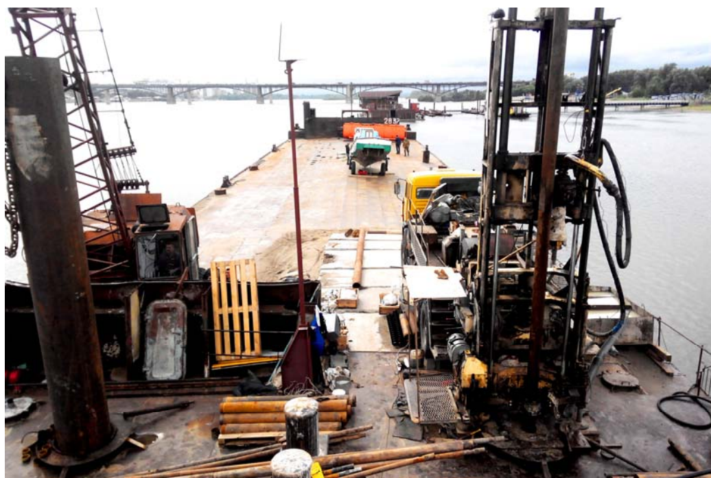
Фото 8. Бурение на опоре №19. На заднем плане Октябрьский мост через р. Обь.
