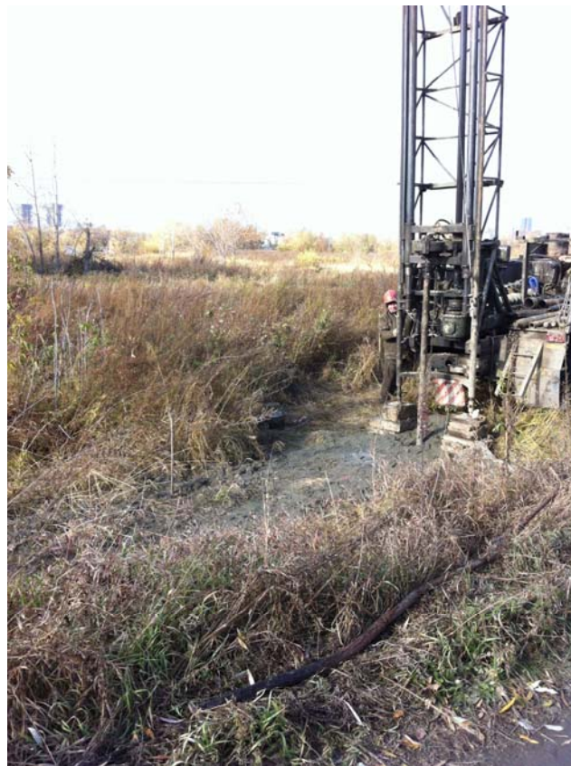
Фото 2. Бурение скважины 218816 (в районе пересечения железной дороги)
