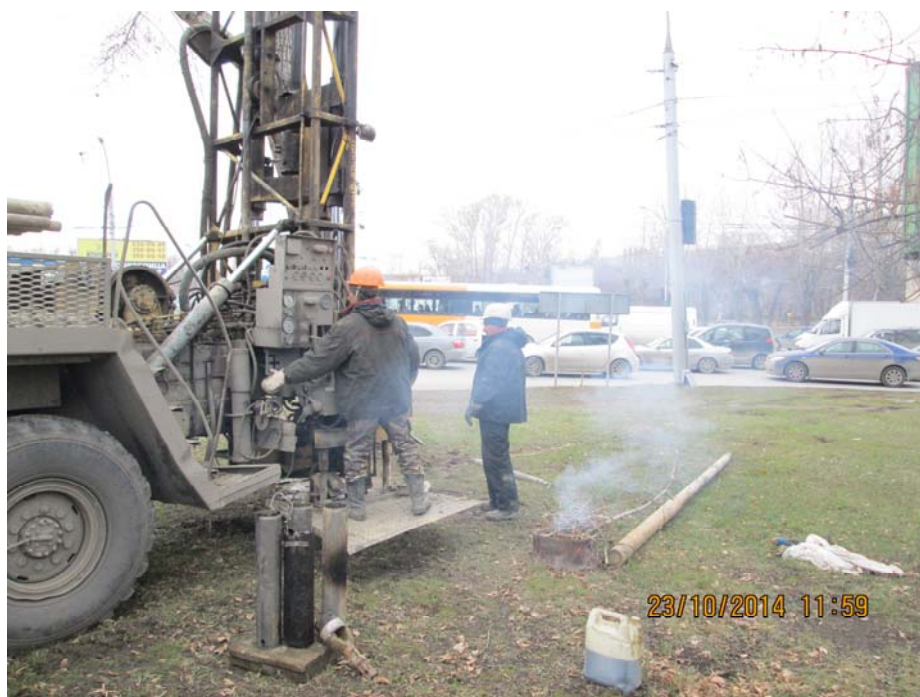
Фото 6. Бурение скважины в районе проезда энергетиков
