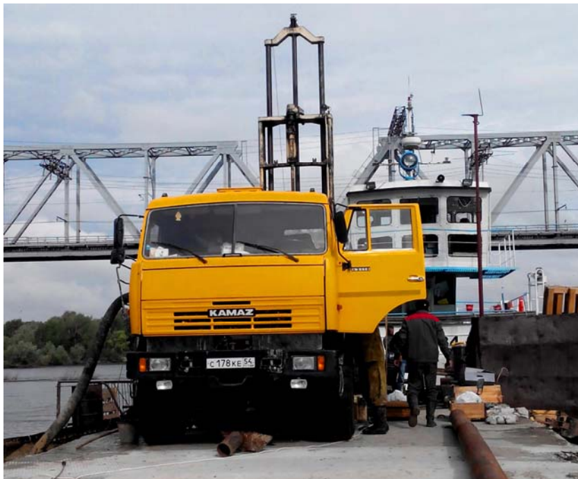
Фото 7. Бурение на опоре № 9. На заднем плане железнодорожный мост через р. Обь
