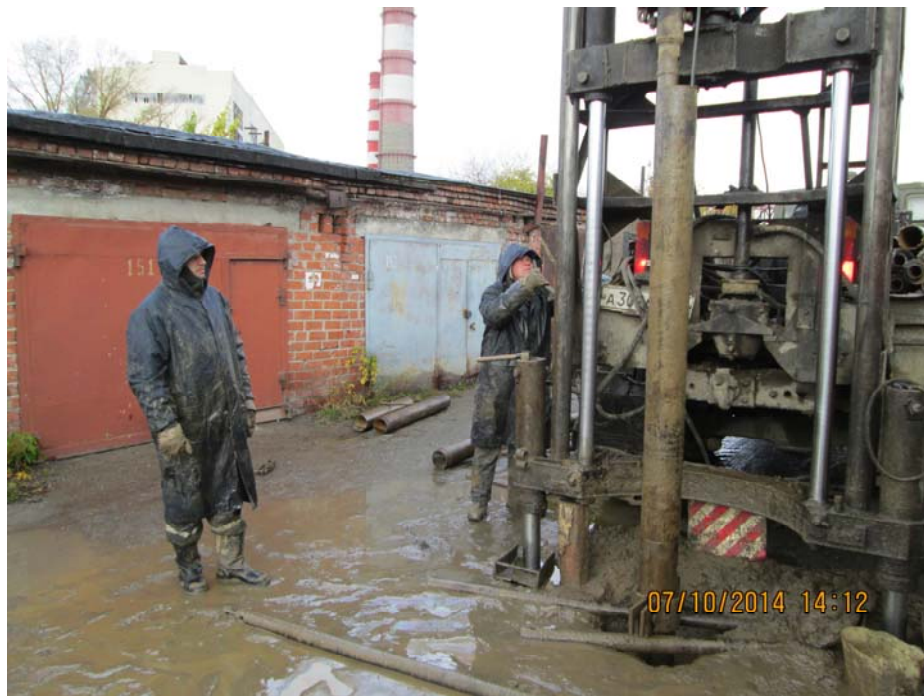
Фото 4. Бурение скважины 218835 в створе основного хода (левый берег)
