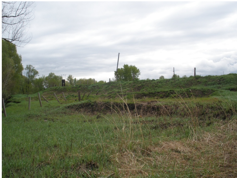
Фото 20. Вид на насыпь.
